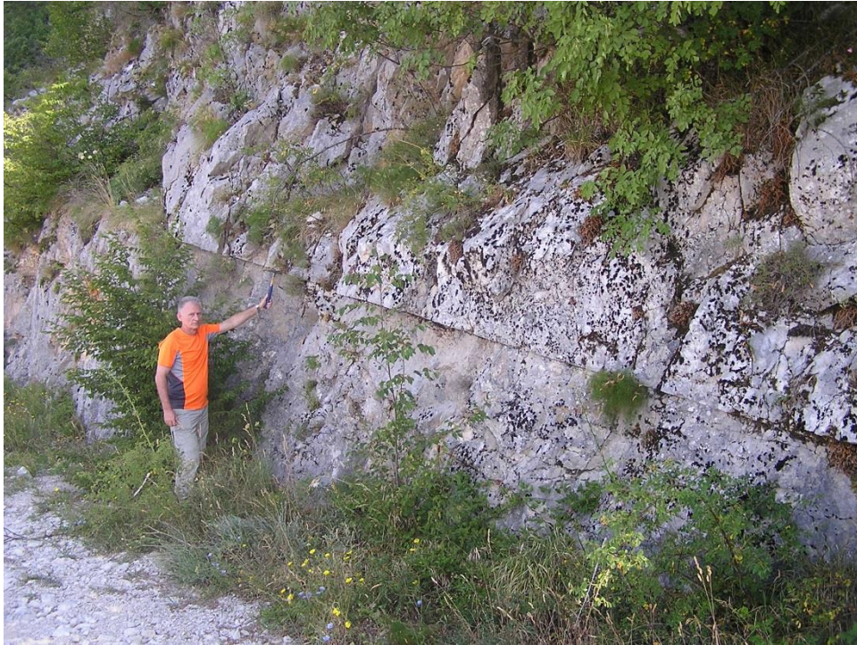
Slika 5.89. Navlačni rasjed Rašpor–Brgudac u zasjeku makadamske ceste za Veprinac. Lokacija točke je 45^{\circ}25'6.7''\text{N} , 14^{\circ}7'3.4''\text{E} .
