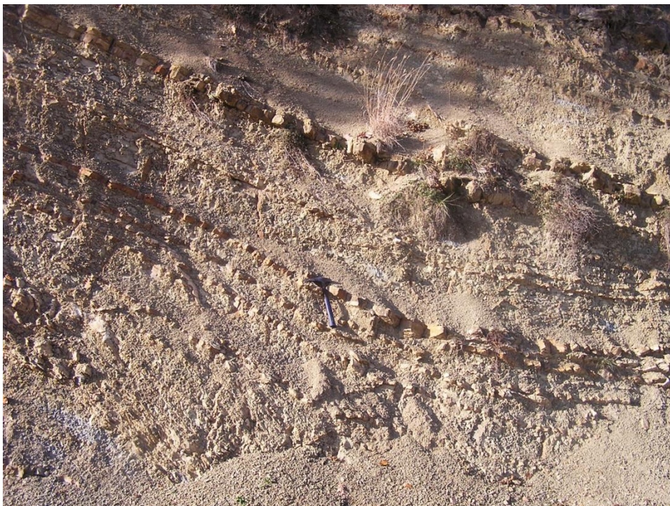
Slika 5.37. Izdanci flišnih naslaga u zasjeku ceste Buzet–Pengari (područje Pazinskoga flišnog bazena). Lokacija: 45°23'41.1"N, 13°58'30.4"E.
