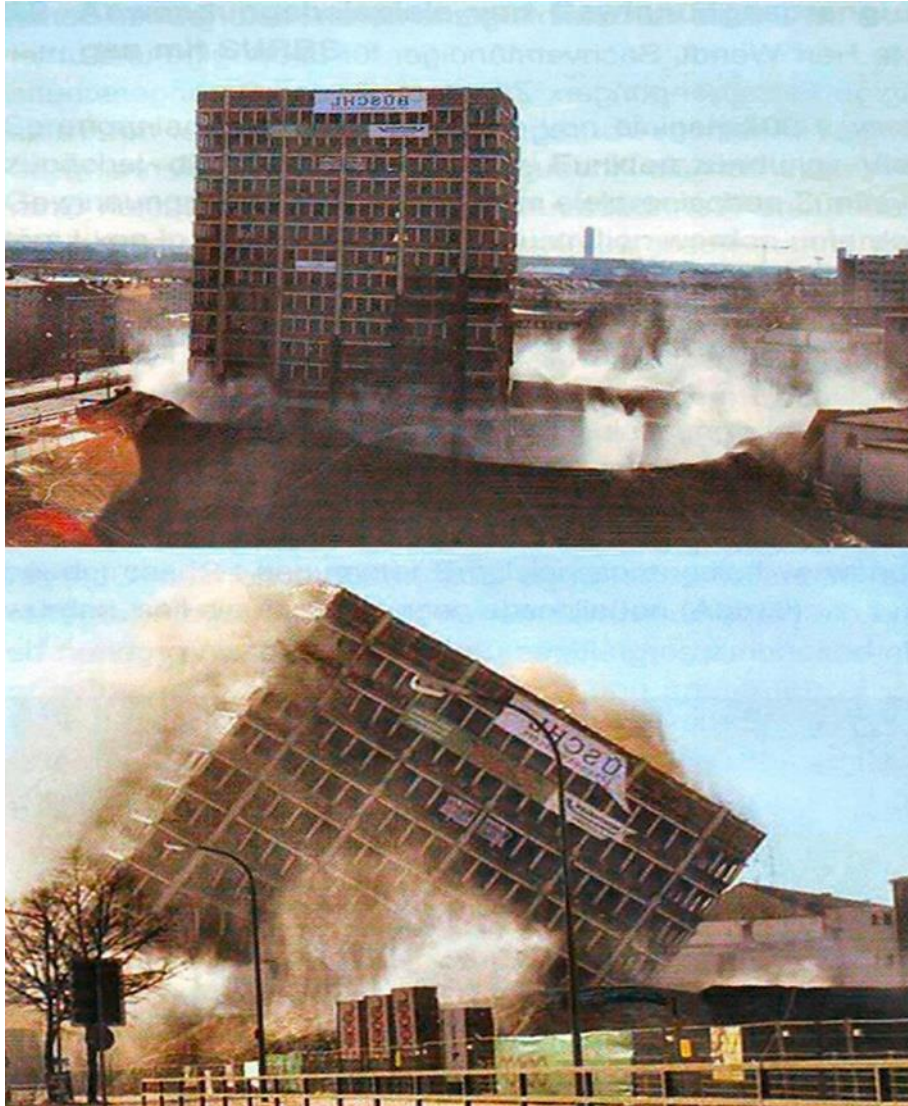
Slika 2-4. Rušenje objekta rotacijom (Ester Z., Dobrilović M., 2016.)
