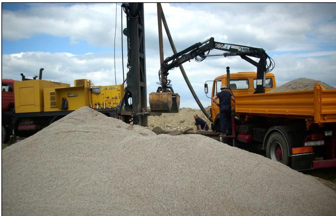
Slika 3-4. Ubacivanje šljunčanog zasipa (fotografija Željka Duića)
