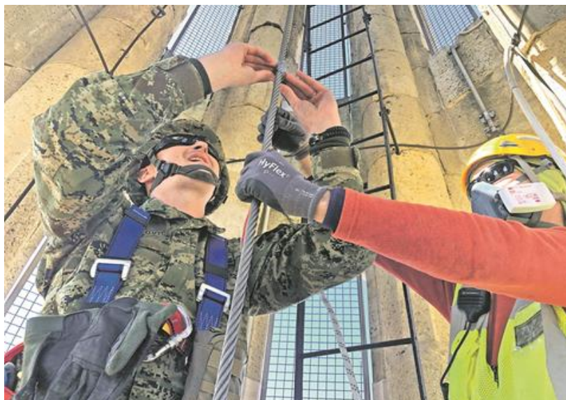
Slika 4-9. Postavljanje eksplozivnog naboja na čelično uže (Bohanek i Dobrilović 2020)
