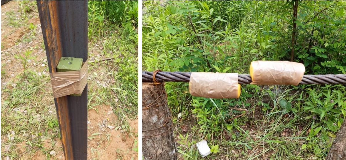
Slika 3-6. Jednostrano i dvostrano postavljanje eksplozivnog naboja.
