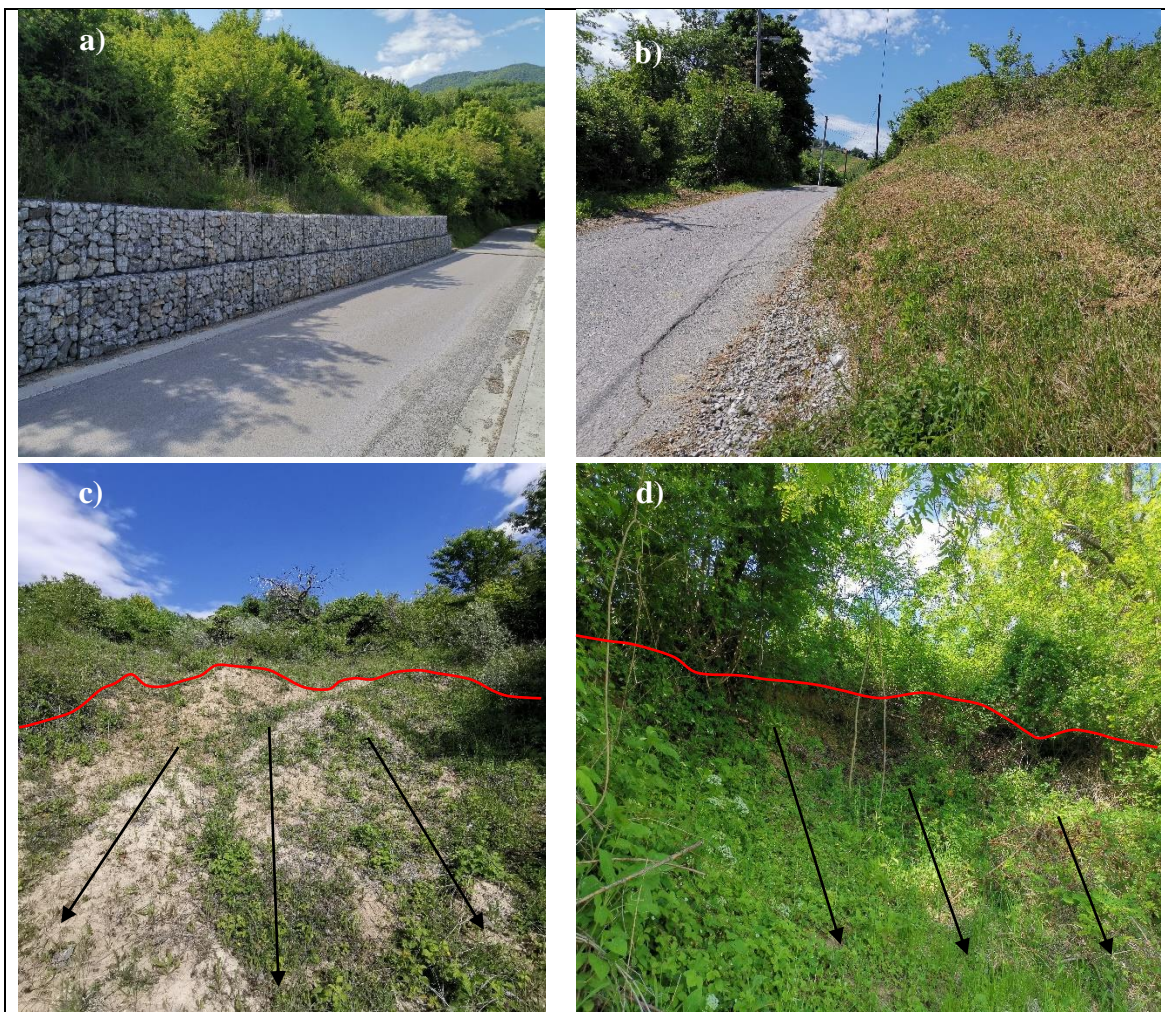
Slika 5. 1. Lokacije nekoliko saniranih i umirenih klizišta na području grada Jastrebarsko
