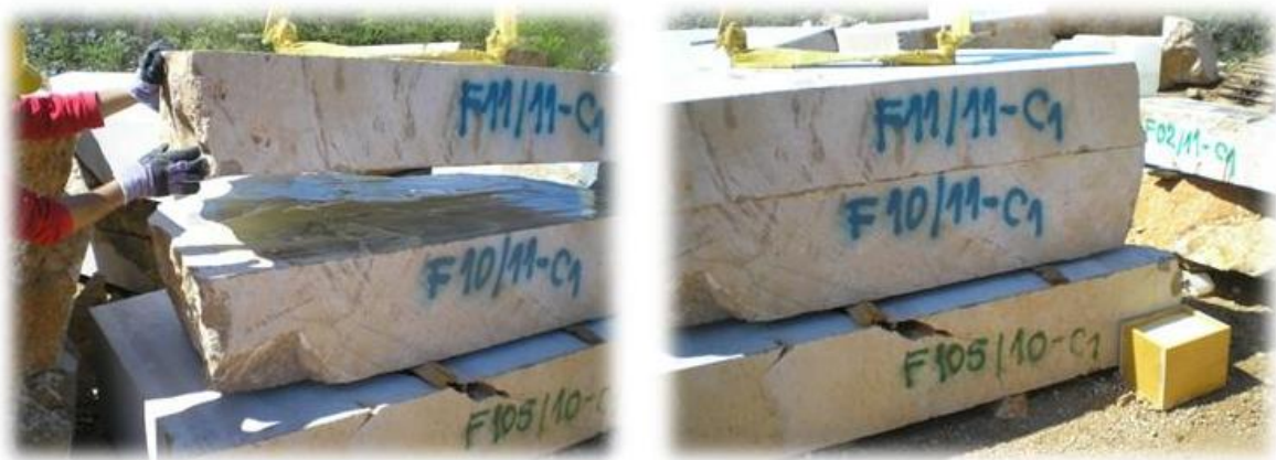
Slika 6.2. Nanošenje jednog bloka na drugi preko tankog sloja urea-silikatne smole MEYKO MP 364 Flex
