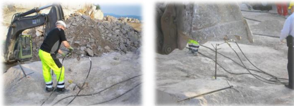
Slika 7.24. Spajanje viskotlačnih crijeva na paker i osiguranje od izlijetanja pakera
