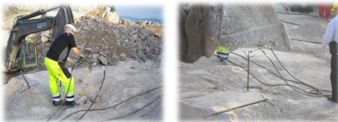
Slika 7.24. Spajanje viskotlačnih crijeva na paker i osiguranje od izljetanja pakera
