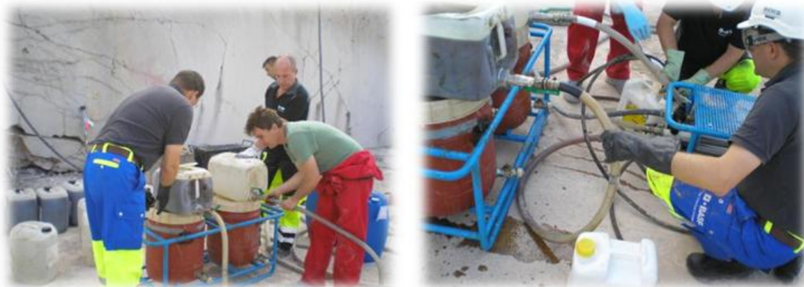
Slika 7.23. Spajanje viskotalčnih cijevi na razervoare
