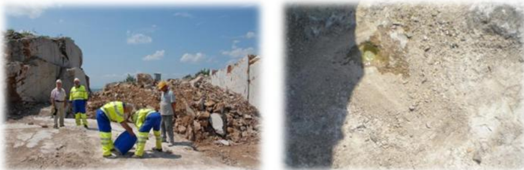
Slika 7.30. Utiskivanje koloidne silike silom gravitacije na istočnom probnom polju
