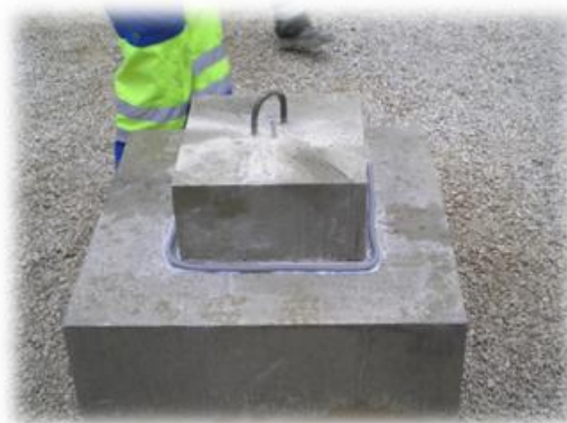
b) blokovi spremni za lijepljenje
