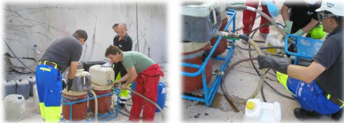
Slika 7.23. Spajanje viskotalčnih cijevi na razervoare
