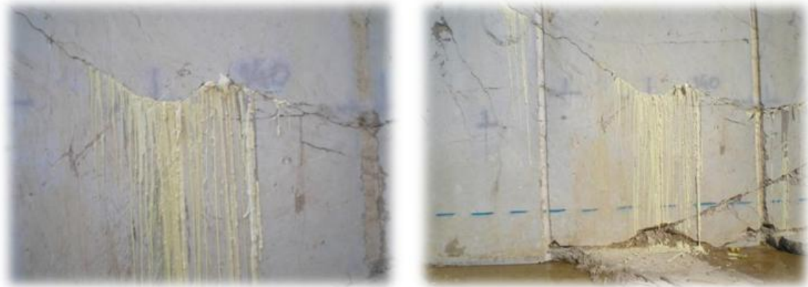
Slika 7.28. Izgled čela etaže nakon utiskivanja u bušotine B2 i B3
