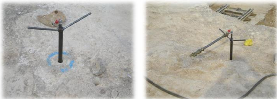
Slika 7.22. Paker usidren u utisnu bušotinu bez i sa spojnom cijevi
