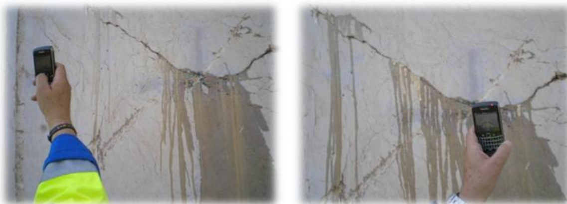
Slika 7.27. Istiskivanje vode i mulja, tijekom utiskivanja urea silikatne smole u bušotinu B2
