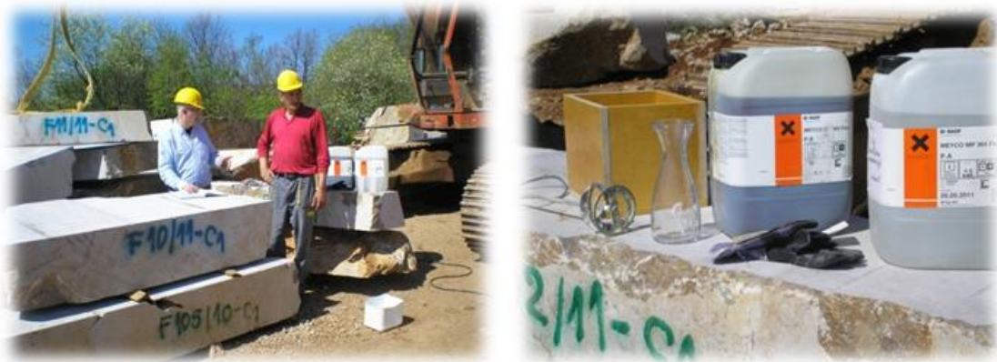
Slika 6.1. Odabir blokova za lijepljenje te pribor i oprema potrebna za obavljanje ispitivanja
