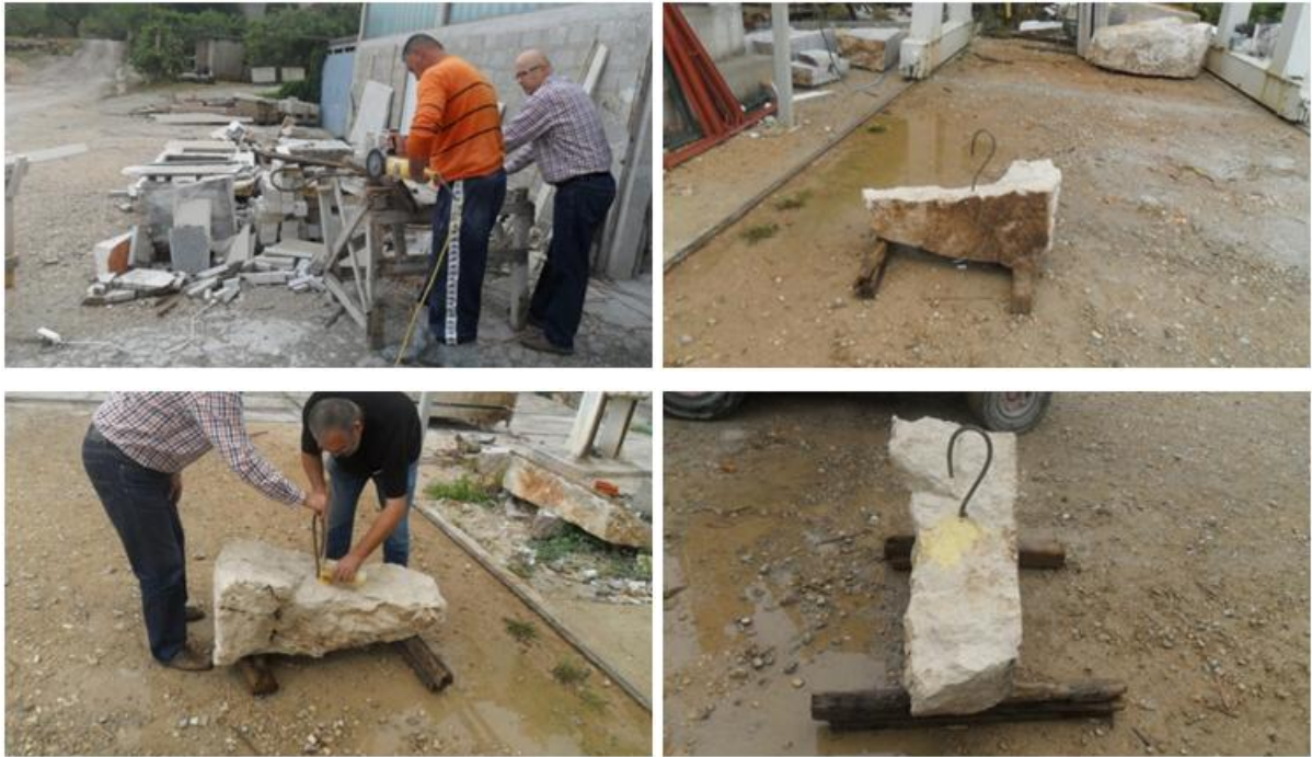
Slika 8.4. Ugradnja metalne šipke u manji kameni komad
