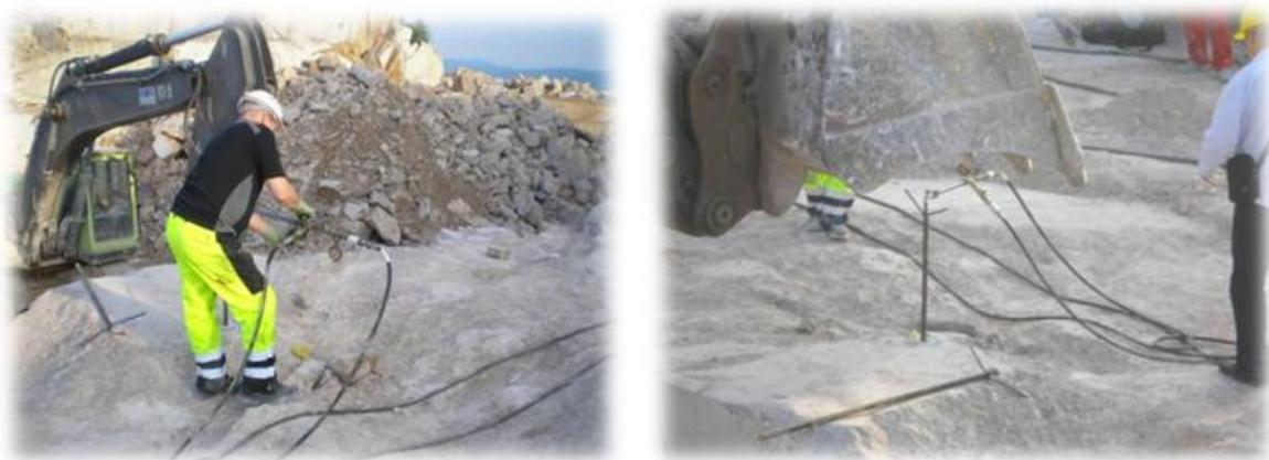
**Slika 7.24. Spajanje viskokotlačnih crijeva na paker i osiguranje od izljetanja pakera**
