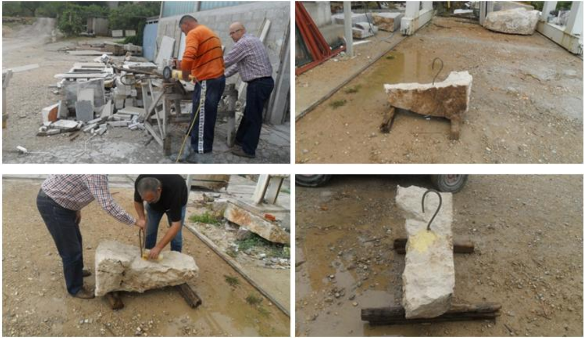
Slika 8.4. Ugradnja metalne šipke u manji kameni komad
