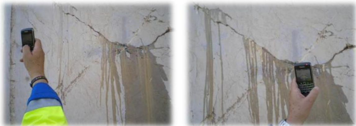
Slika 7.27. Istiskivanje vode i mulja, tijekom utiskivanja urea silikatne smole u bušotinu B2
