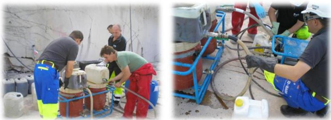
**Slika 7.23. Spajanje viskokotlačnih cijevi na razervoare**
