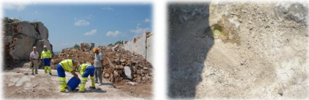
Slika 7.30. Utiskivanje koloidne silike silom gravitacije na istočnom probnom polju
