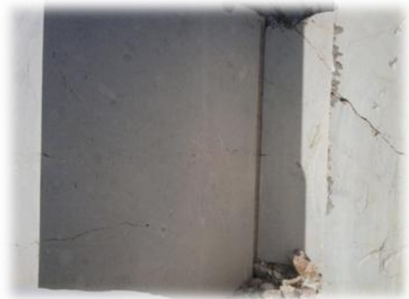
b) Izrađeni trapezni usjek
