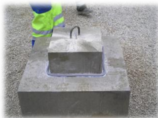
b) blokovi spremni za lijepljenje
