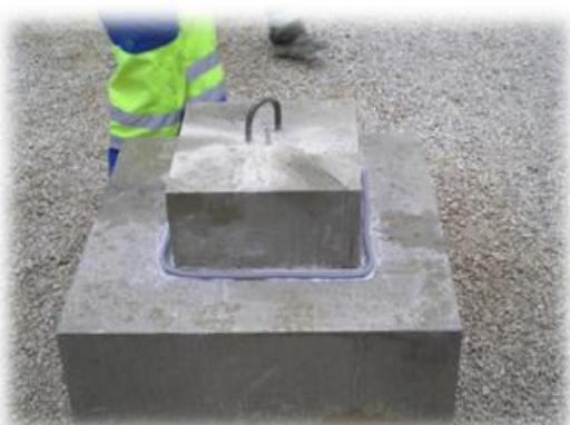
b) blokovi spremni za lijepljenje
