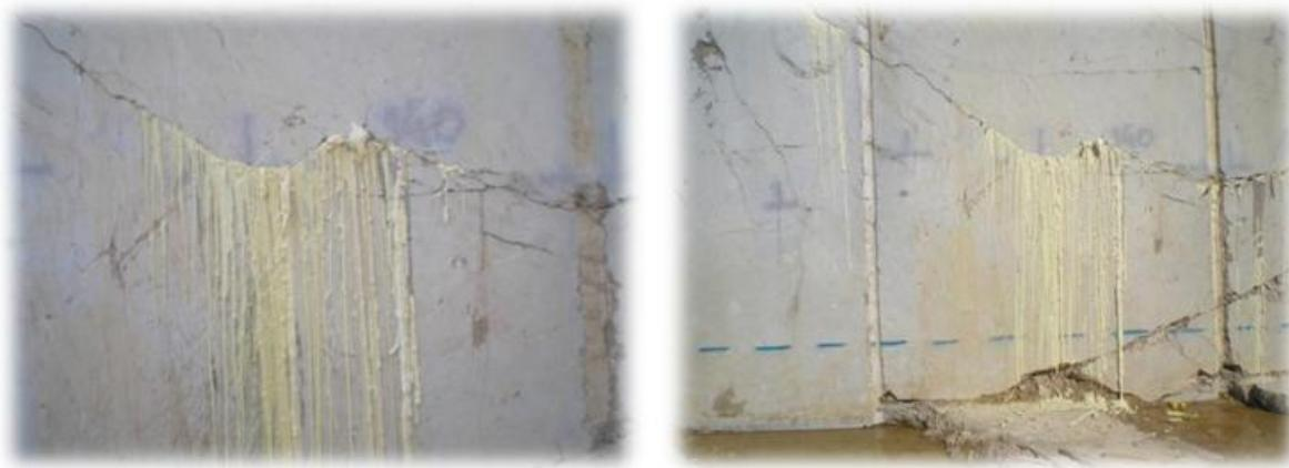
**Slika 7.28. Izgled čela etaže nakon utiskivanja u bušotine B2 i B3**
