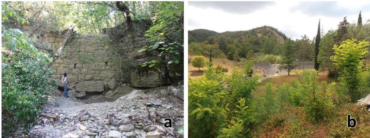
Slika 151 – Mjere zaštite od erozije na području središnje Istre – a) preljev; b) retencija
