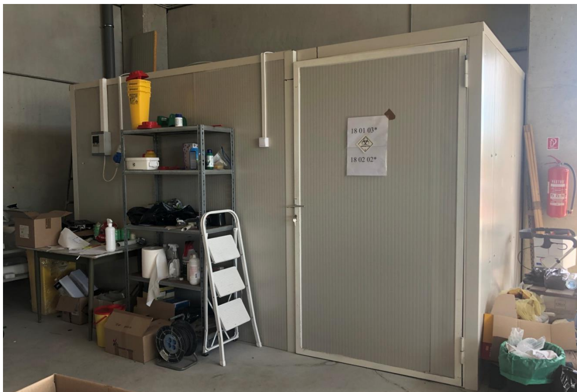
Slika 3-9. Rashladna komora za skladištenje infektivnog otpada
