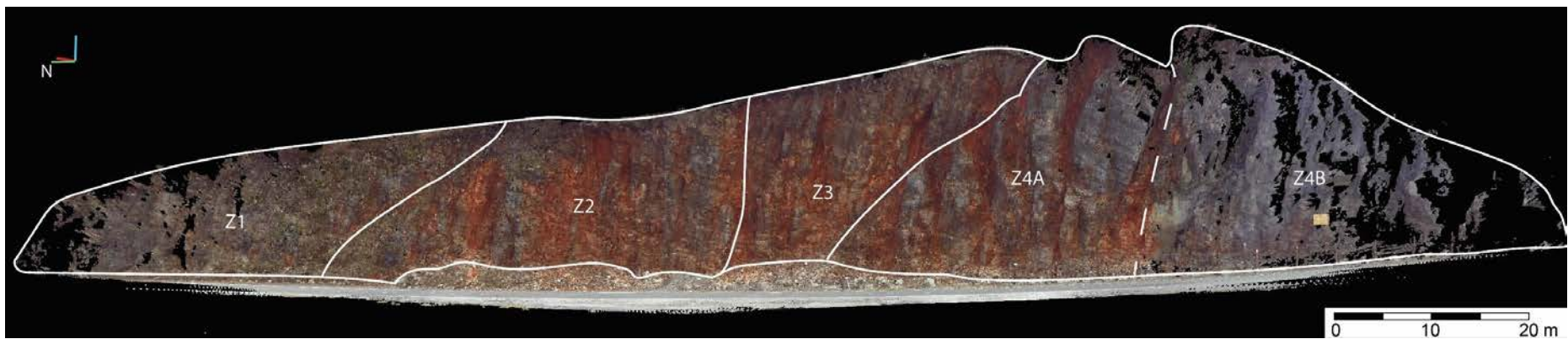
Slika 5.73. Pogled na stijenski zasjek Špičunak s ucrtanim granicama inženjerskogeoloških zona Z1, Z2, Z3, Z4A i Z4B
