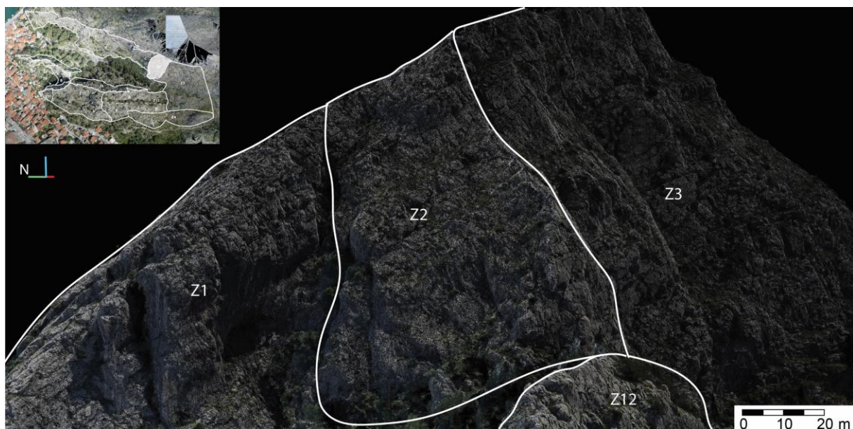
Slika 5.5. Pogled na inženjerskogeološku zonu Z2 s ucrtanim granicama inženjerskogeoloških zona Z1, Z2, Z3 i Z12 na visoko-rezolucijskom digitalnom modelu istraživanih stijenskih kosina.
