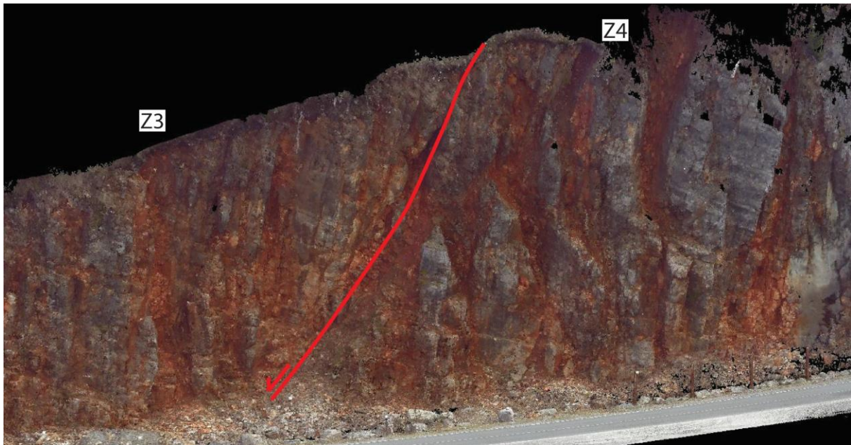
Slika 4.41. Podjela dijela stijenskog zasjeke na lokaciji Špičunak na dvije zone gdje granicu između zona predstavlja normalni rasjed pri čemu je vidljiva razlika u stupnju trošnosti stijenske mase i u geometrijskim značajkama diskontinuiteta u svakoj pojedinoj zoni.
