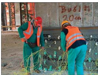
Slika 4.7. Povezivanje minskih bušotina. Figure 4.7. Connecting the blasting holes.
