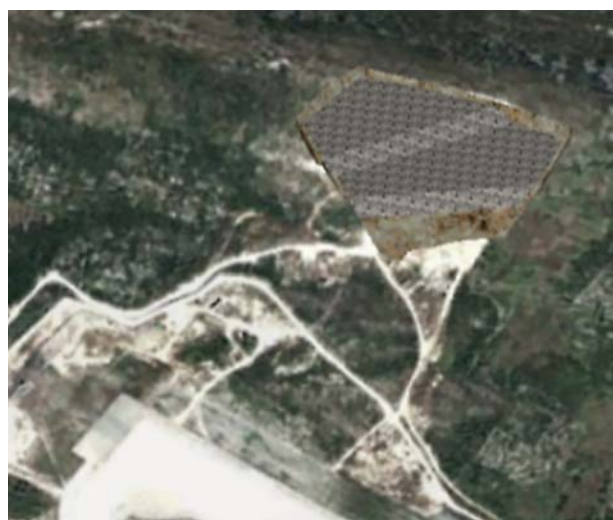
Prikaz površinskog kopa "Močići" nakon tehničke sanacije i odloženog građevnog otpada. Showing the "Močići" open pit after technical renovation and construction waste is landfilled.
