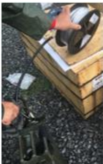
Slika 4-14. Punjenje i montaža kapilarnog voda (INA d.d., 2019)
