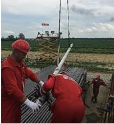
Slika 4-4. Zadizanje i odsjedanje sekcije motora i telemetrijske jedinice (INA d.d., 2019)
