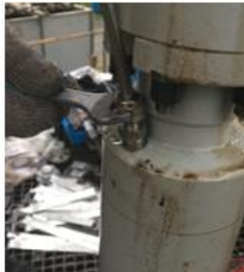
Slika 4-14. Punjenje i montaža kapilarnog voda (INA d.d., 2019)
