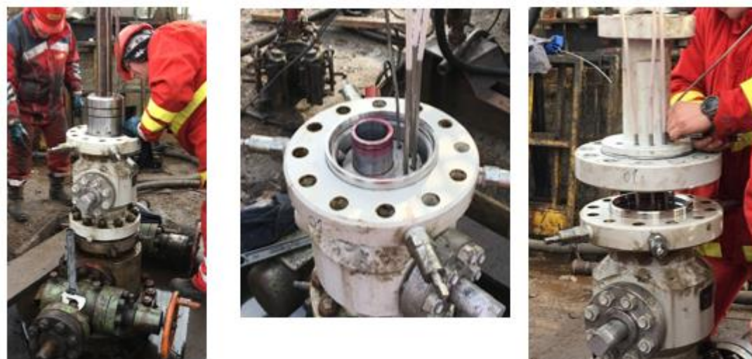
Slika 4-23. Odsjedanje uzlaznog niza i spajanje pokrovne prirubnice (INA d.d., 2019)
