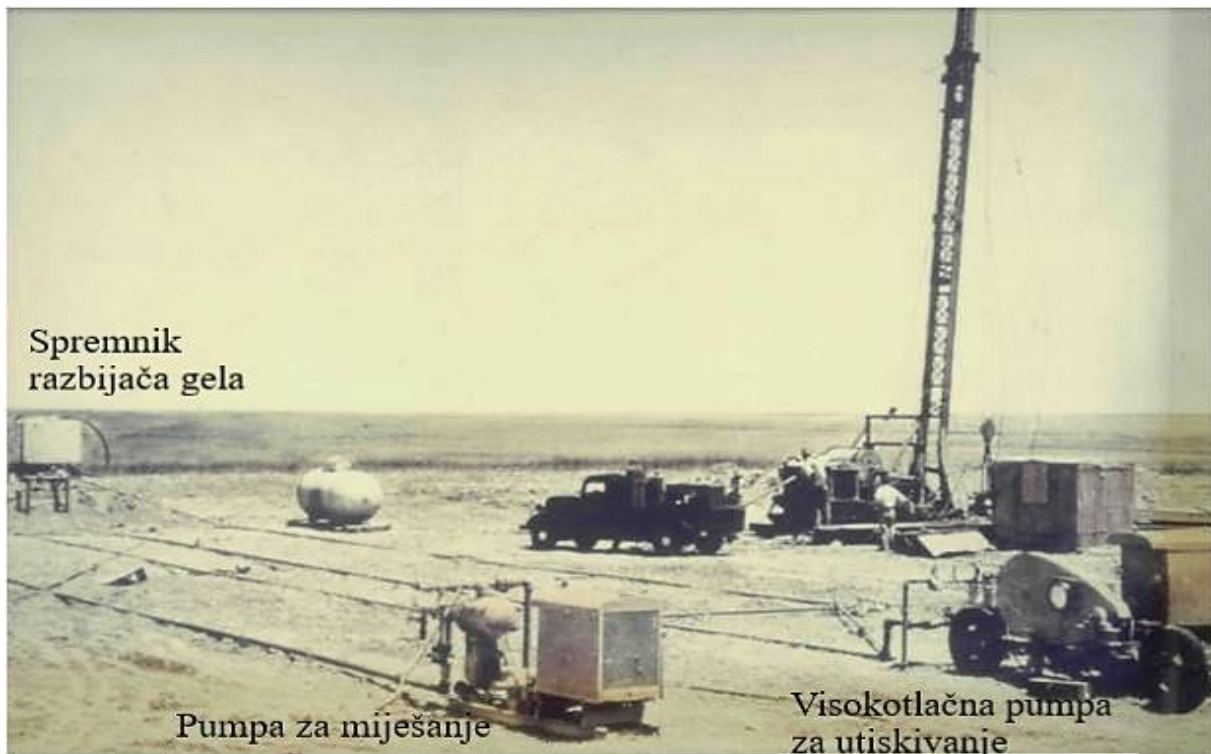
Slika 5-1. Izvedba prvog hidrauličkog frakturiranja 1947. godine, polje Hugoton, Kansas (Suchy i Newell, 2012)
