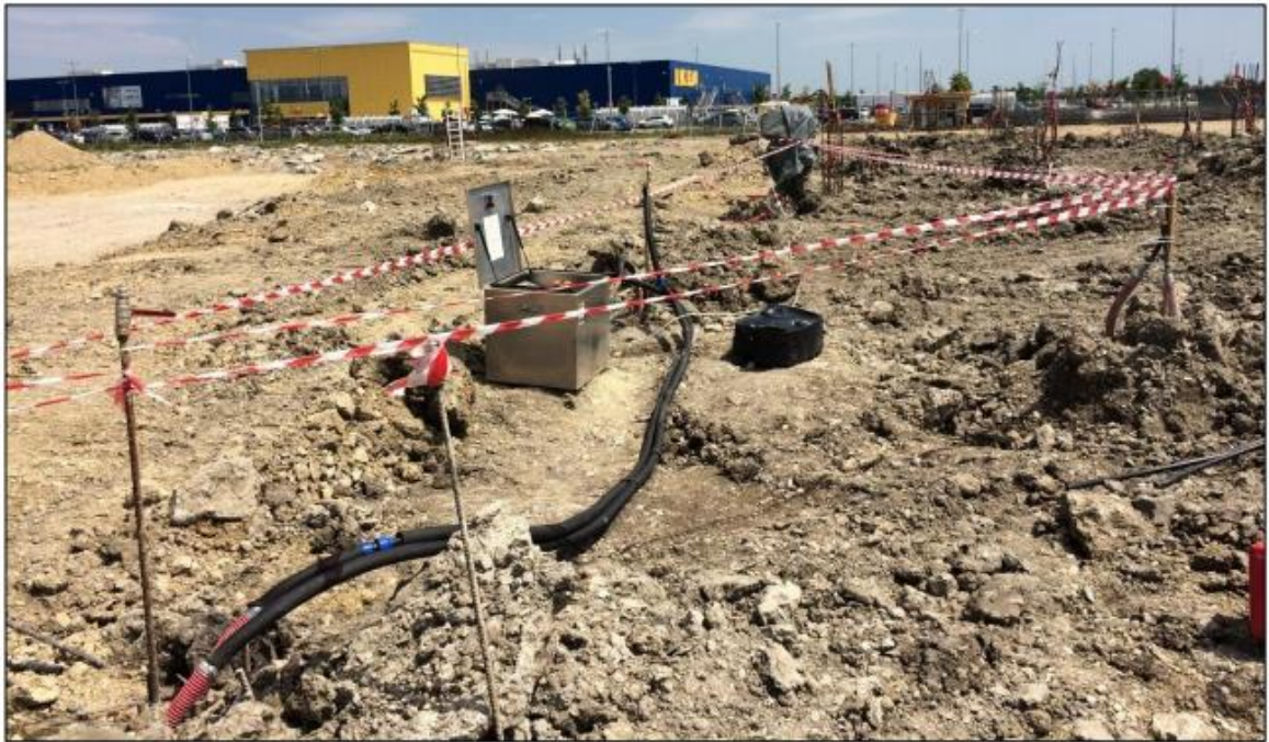
Slika 5.3 Oprema TRT-a i izvođenje testa na lokaciji
