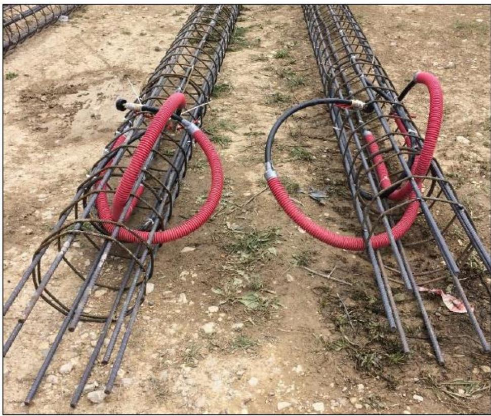
Slika 5.1 HDPE cijevi postavljene na armturni koš
