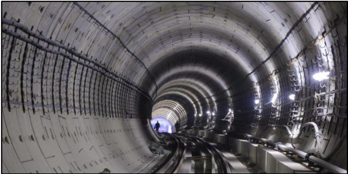
Slika 2-4. Kružni oblik tunela (Primorac, 2019)
