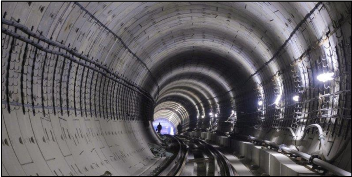
Slika 2-4. Kružni oblik tunela (Primorac, 2019)
