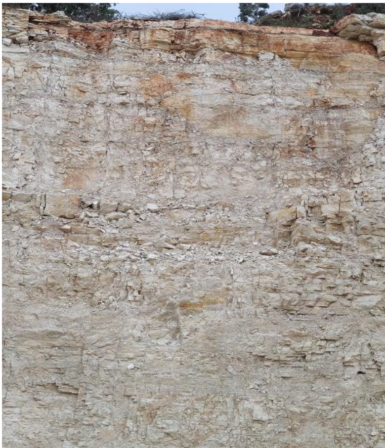
Slika 2-4 Otvorena etaža površinskog kopa "Tambura"
