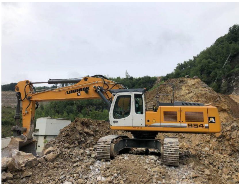
Slika 4-13 Rovokopač Liebherr R 954 (Liebherr, n.d.)
