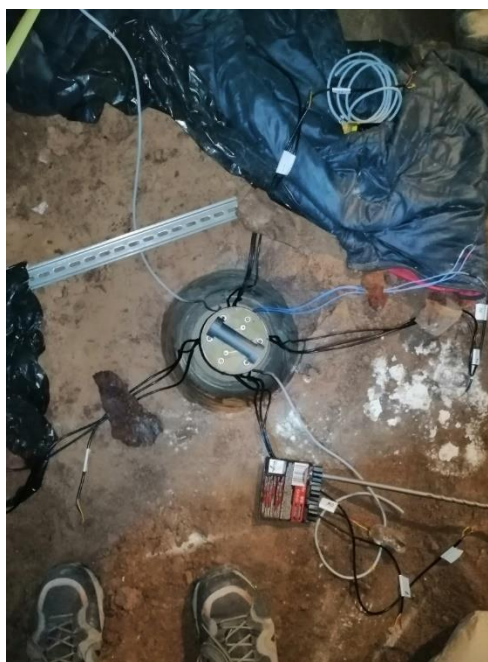
Slika 3-10. Ugradnja senzora, bentonitne ispune i razvrstavanje kablova
