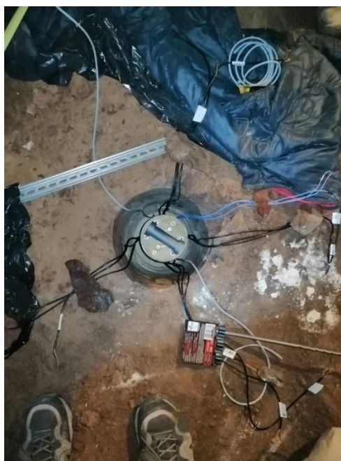
Slika 3-10. Ugradnja senzora, bentonitne ispune i razvrstavanje kablova
