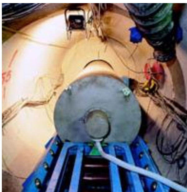
Slika 2-15. Ugradnja grijača u bentonitni blok (Grimsel, 2020)
