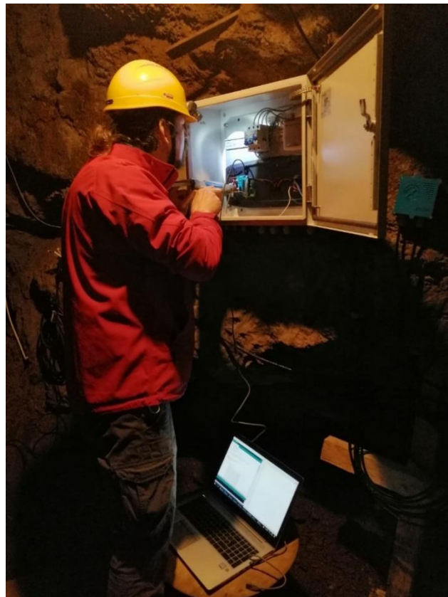
Slika 3-12. Spajanje senzora za mjerenje temperature i vlažnosti
