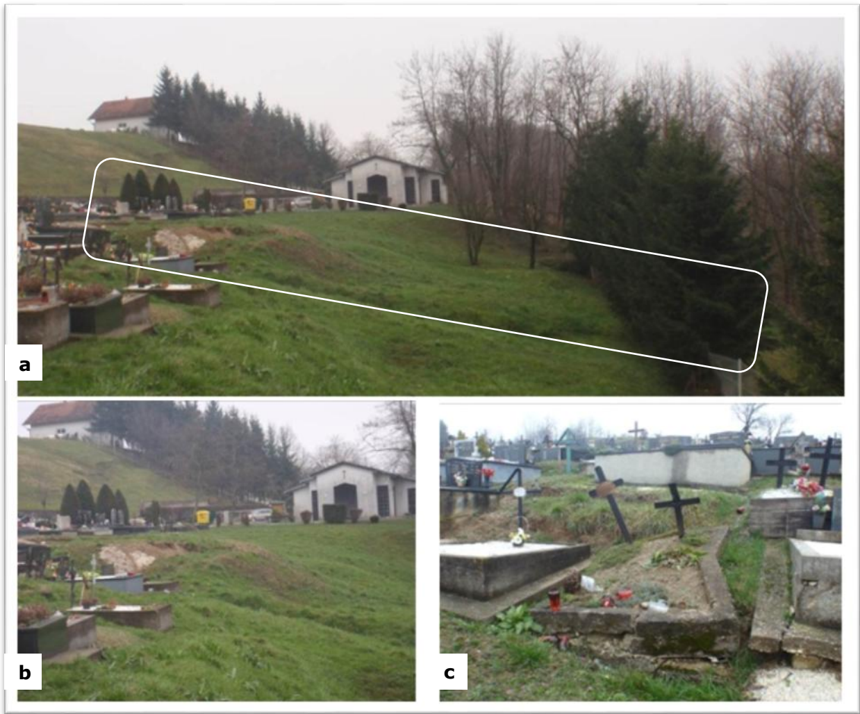
Slika 3. 1 Klizište 1 (uokvireno bijelom linijom) aktivirano 4. travnja 2013. godine (fotografirano 4.3.2014): (a) pogled na klizište; (b) pogled na gornji dio klizišta i oštećene grobove; (c) oštećenja na grobovima.
