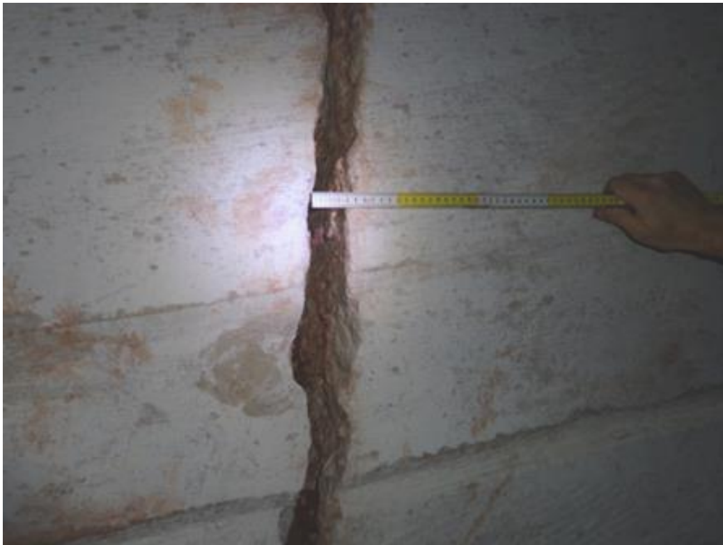
Slika 3-4. Mjerenje zijeva na terenu
