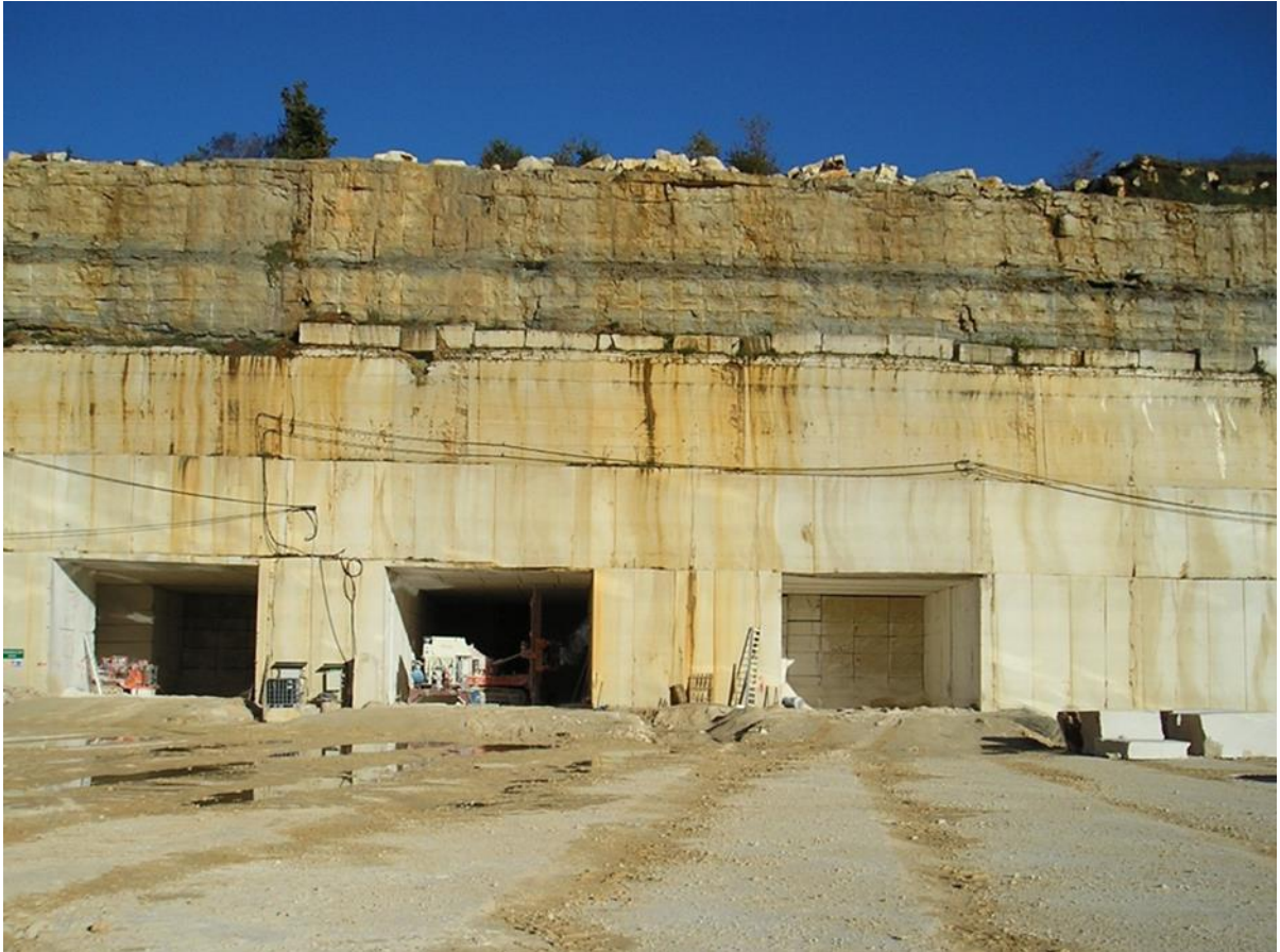
Slika 3-2. Naslage ležišta na čelu radilišta
