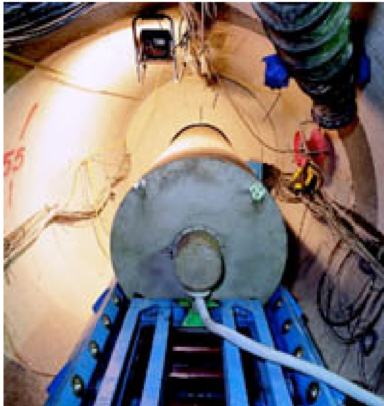
Slika 4-7. Ugradnja grijača u bentonitni blok (Grimsel, 2015)
