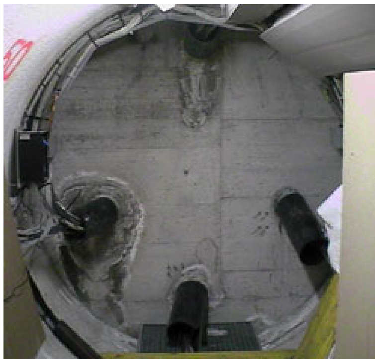
Slika 4-9. Betonski čep (Grimsel, 2015)
