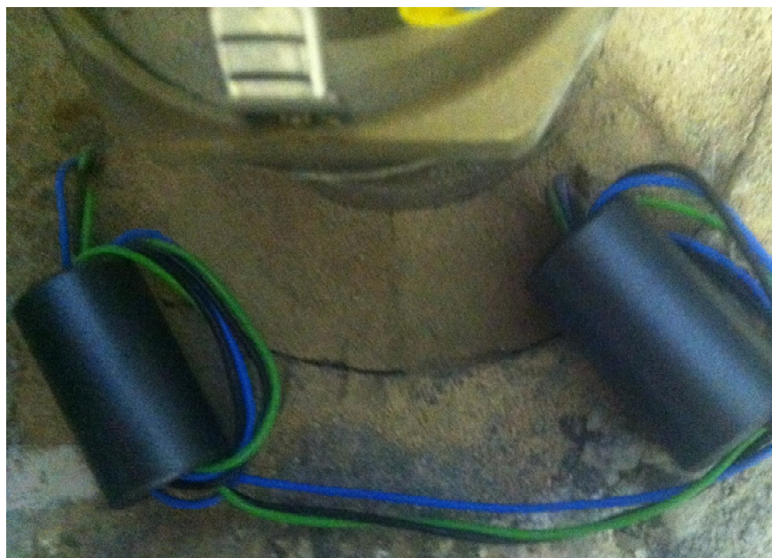
Slika 6-6. Pukotina između bentonitnog tampona i stijene, nastala nakon završetka ispitivanja i hlađenja sustava
