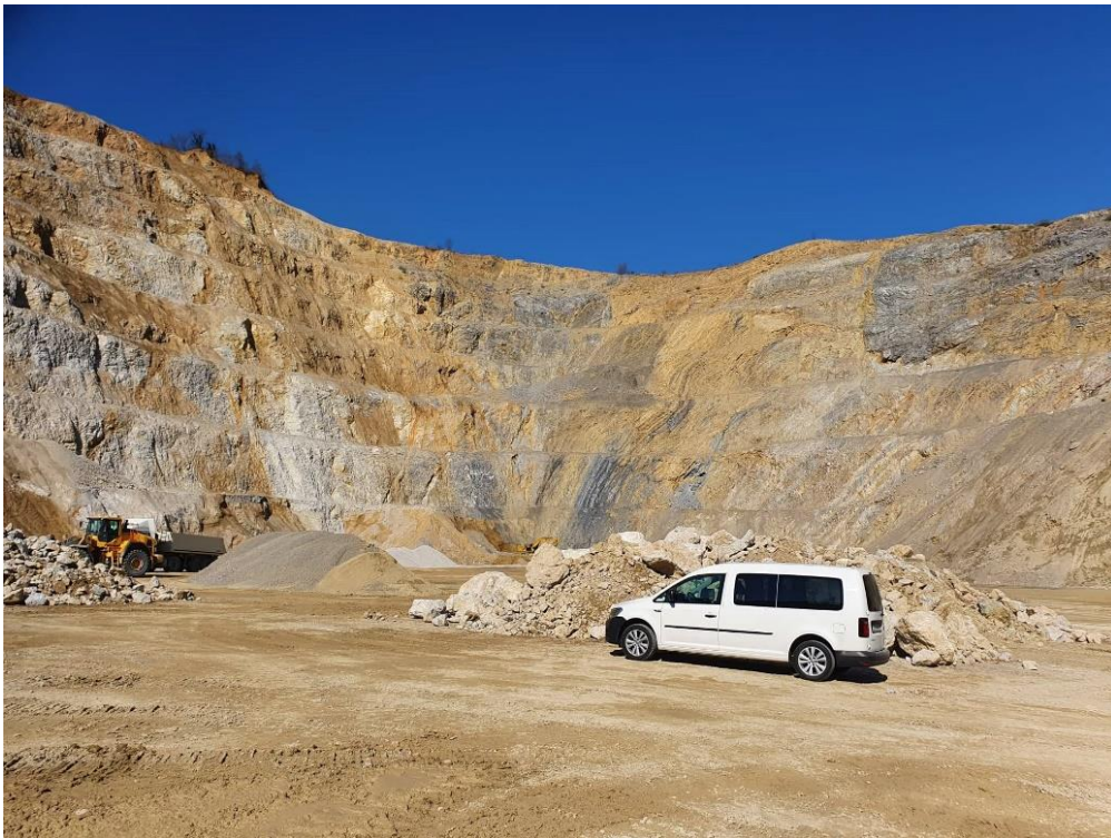
Slika 2.4. Površinski kop na eksploatacijskom polju "LOVNO-LOVNO 2"
