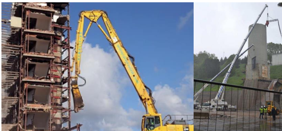
Slika 3-2-1. Rušenje dimnjaka pomoću hidrauličnih kliješta kрана (Martin-Consuegra, 2021)
