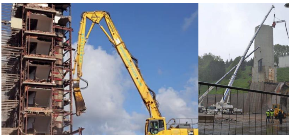
Slika 3-2-1. Rušenje dimnjaka pomoću hidrauličnih kliješta kрана (Martin-Consuegra, 2021)
