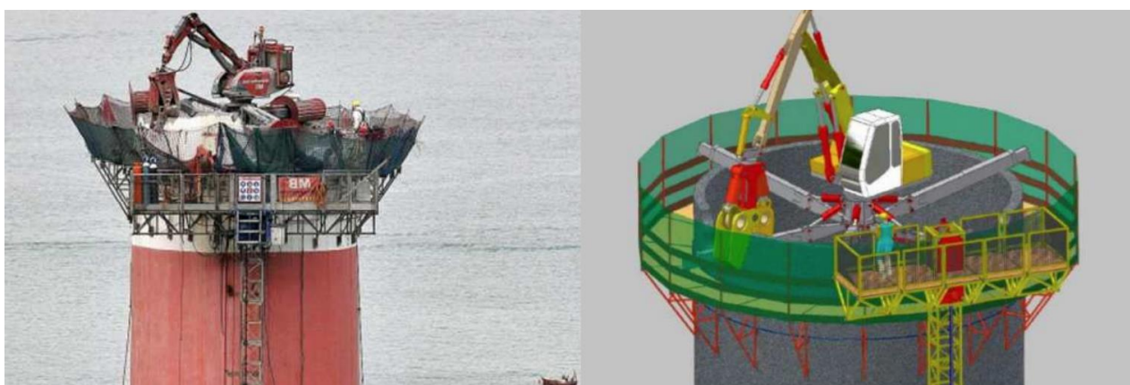
Slika 3-3-1. Rušenje dimnjaka pomoću izgrađene platforme na vrhu dimnjaka (Martin-Consuegra, 2021)
