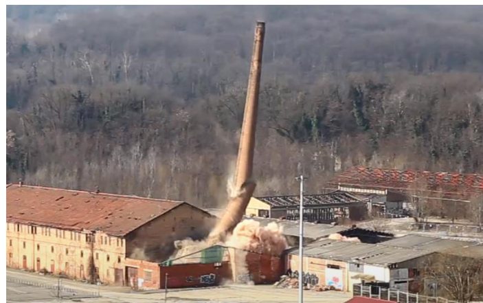
Slika 5-2. Rušenje rotacijom dimnjaka ciglane Zagreb (Stanzi, 2021)
