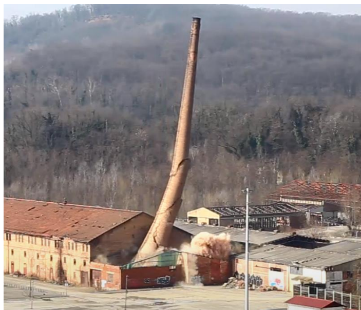
Slika 5-1. Shema rotacijske metode ( Ester i Dobrilović, 2016.)
