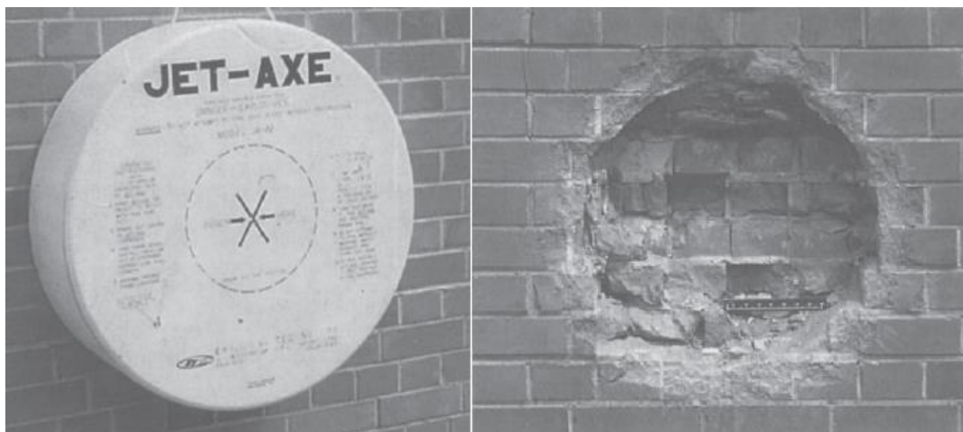
Slika 6-23 Primjer korištenja kumulativnog naboja u dodiru sa zidom (Weickert, 1998)
