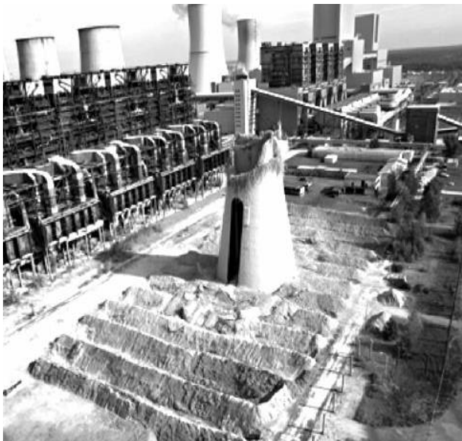
Slika 5-6 Ostatak nakon rušenja ((Melzer,2015 )
