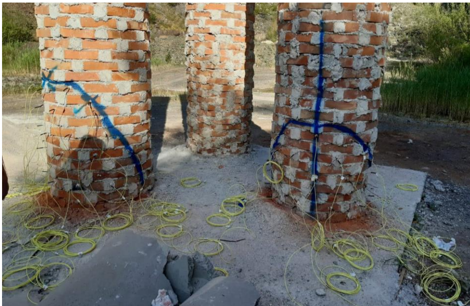
Slika 8-8 Prikaz postavljanja sustava iniciranja kod ciglenih dimnjaka
