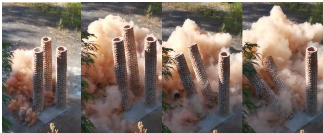
Slika 11-2 Miniranje betonskih dimnjaka
