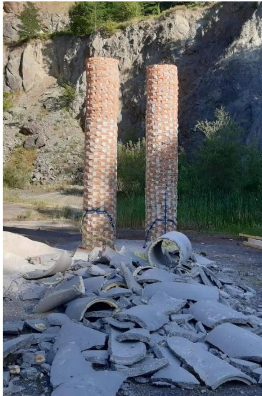
Slika 11-4 Učinak eksploziva na betonskom dimnjaku
