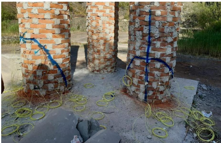
Slika 8-8 Prikaz postavljanja sustava iniciranja kod ciglenih dimnjaka
