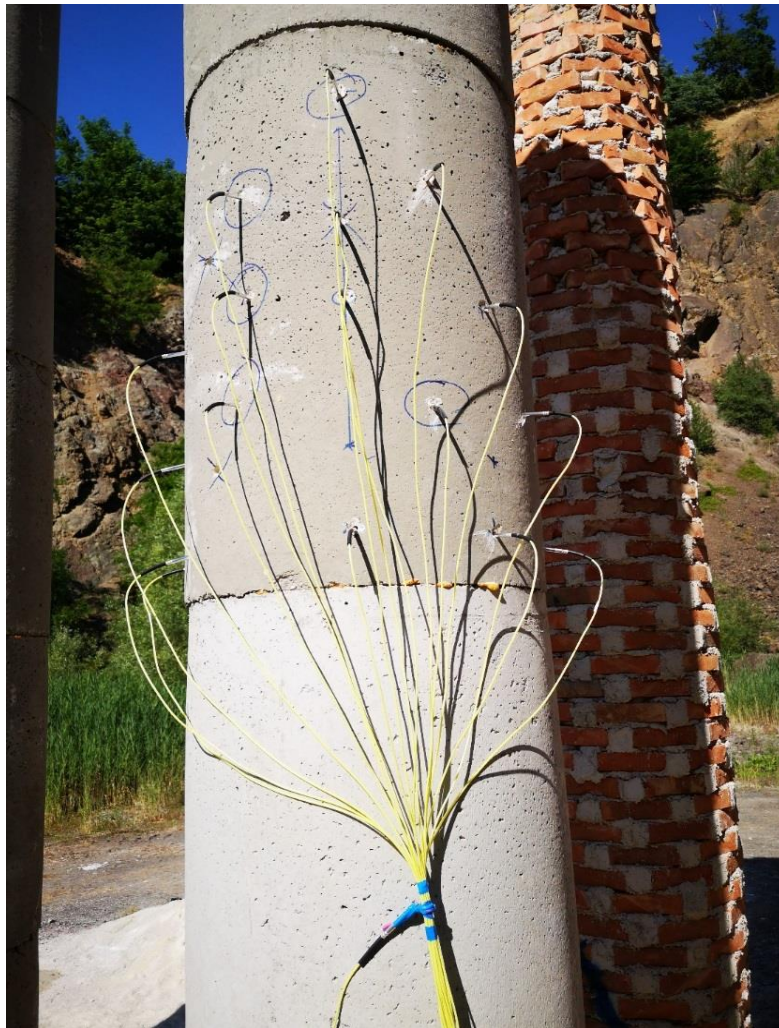
Slika 8-6 Prikaz sustava iniciranja gornjeg zaloma kod betonskog dimnjaka rušenog u dvije faze
