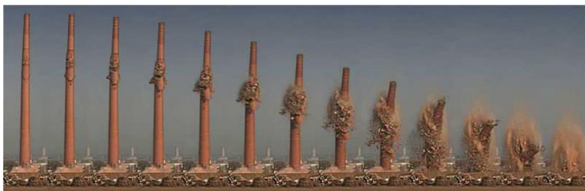
Slika 5-1 Faze rušenja dimnjaka u bivšoj pivovari Henninger ((Martin-Consuegra,2021 )
