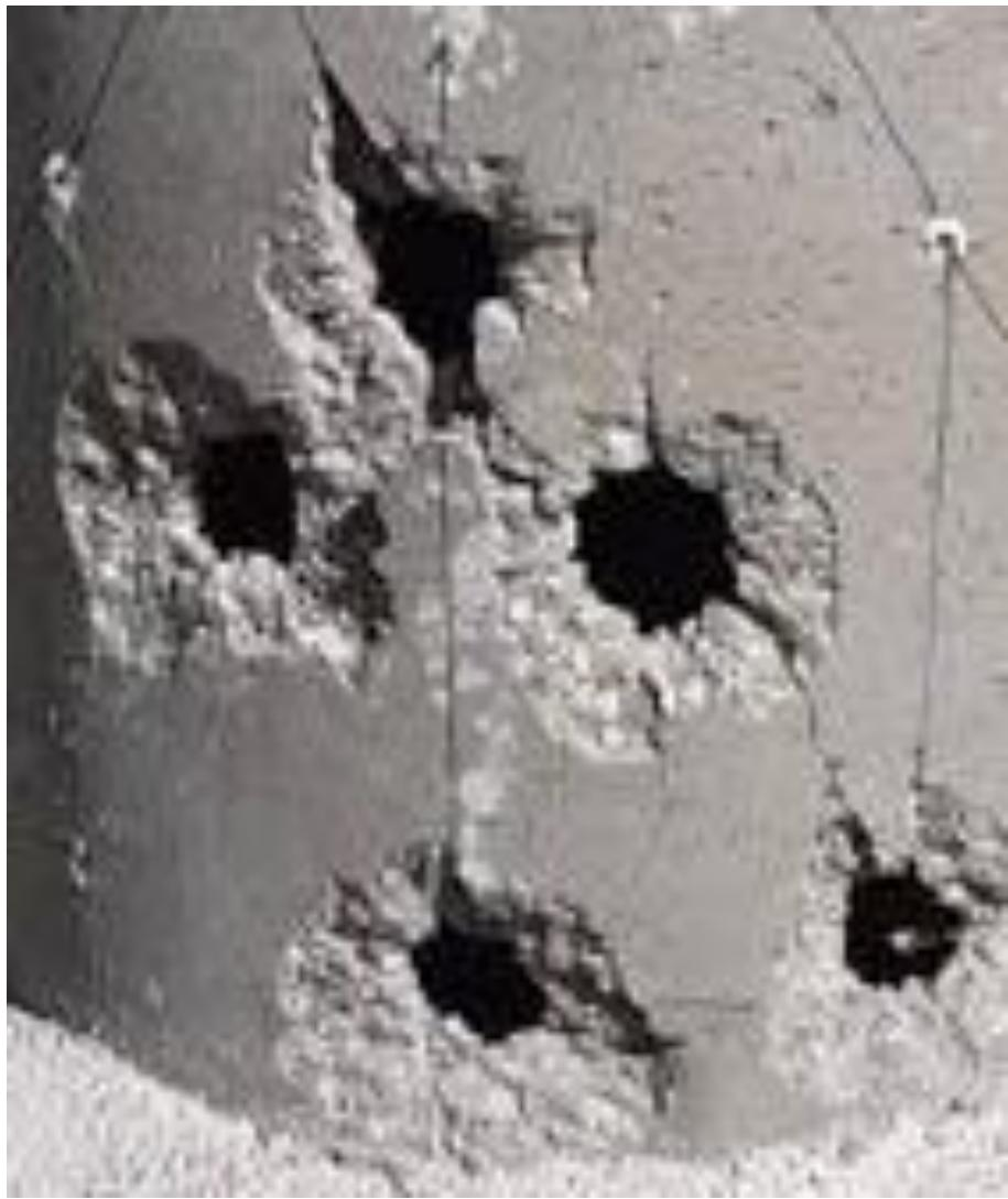
**Slika 11-3** Učinak eksploziva na betonskom dimnjaku
