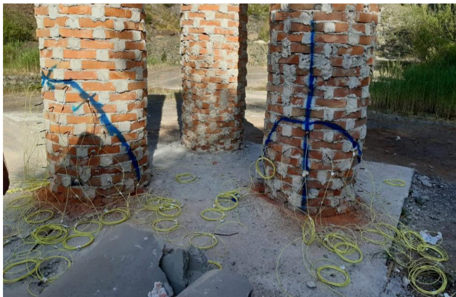
Slika 8-8 Prikaz postavljanja sustava iniciranja kod ciglenih dimnjaka
