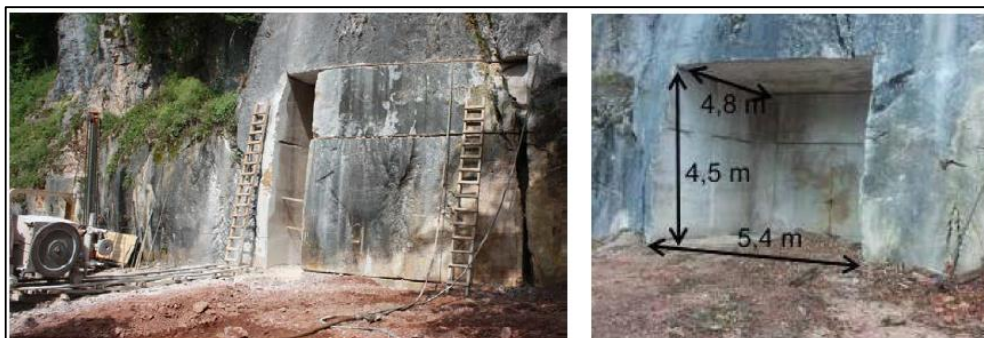
Slika 4-16. Otvaranje i razvoj galerije sjekačicom i dijamantnom žičnom pilom (RBJ–Crvene stijene)
