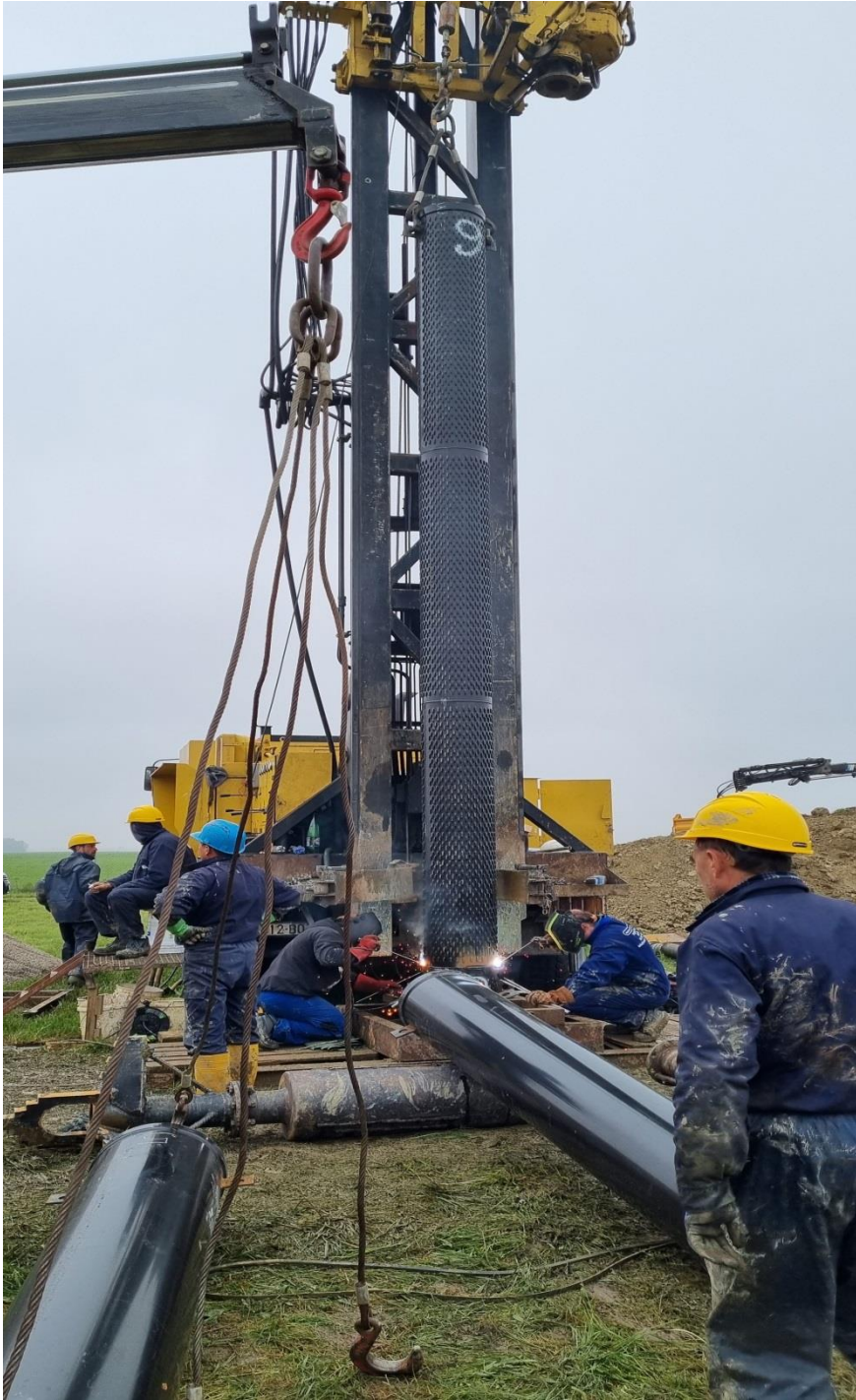
Slika 10: Postavljanje mostićavog sita u bušotinu
