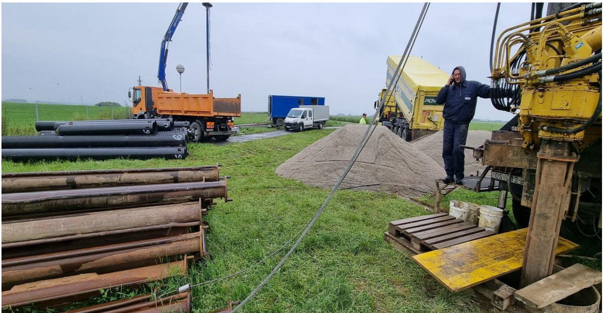
Slika 6: Bušenje zdenca Z-14 reverznom metodom
