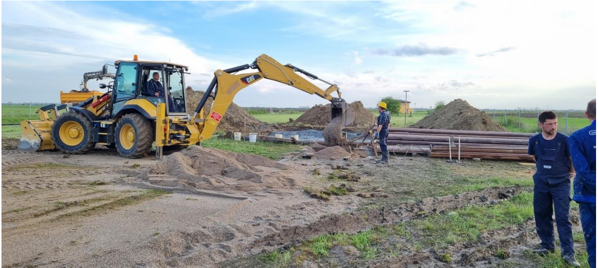
Slika 12: Ubacivanje šljunčanog zasipa
