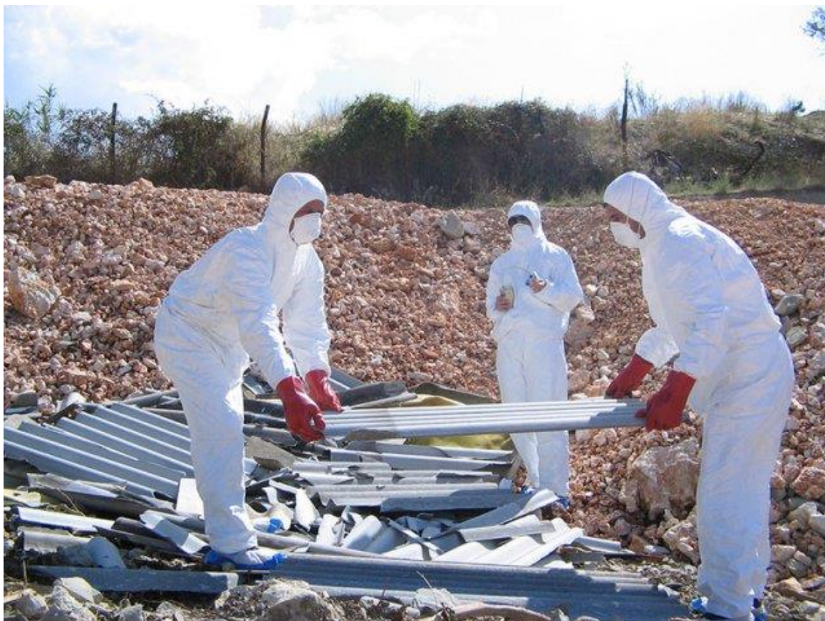
Slika 2-5. Rukovanje azbestom na adekvatan način (Cian d.o.o., 2020)
