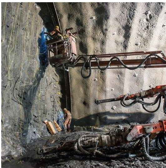
Slika 3-3. Iskop tunela tradicionalnom metodom bušenja i miniranja (Spajanje bušotina, 2016.)
