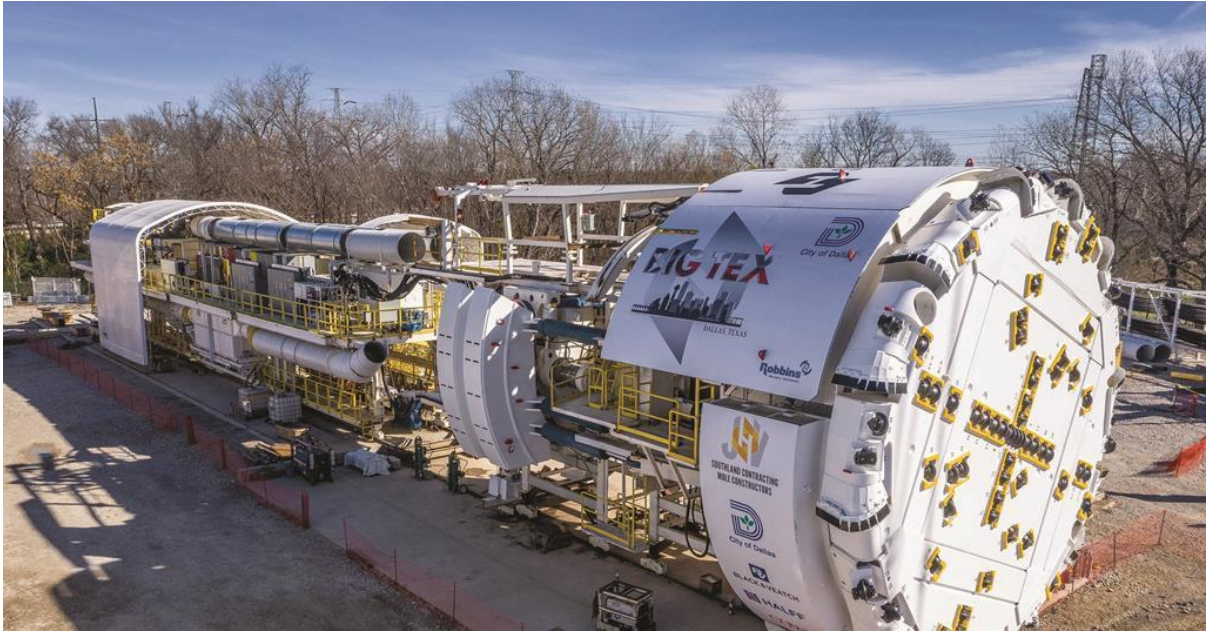
Slika 3-2. TBM za iskop odvodnog tunela (TBM, 2020.)
