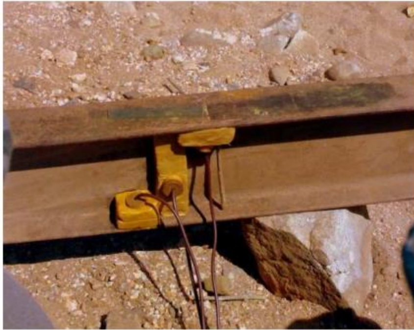
Slika 3-4. Primjena plastičnog eksploziva za rezanje metala (Bohanek i sur., 2013)
