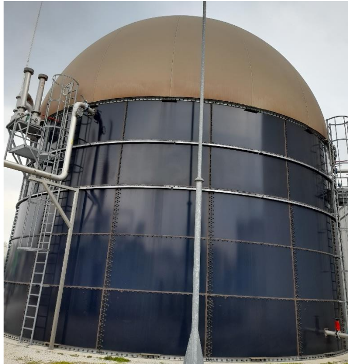
Slika 4-5. Spremnik za bioplin na vrhu fermentora (Agroproteinka d.d., 2021)
