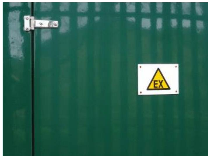
**Slika 4-1.** Način označavanja ugroženih prostora eksplozivnom atmosferom (LABELSOURCE 2015).
