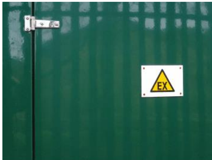
Slika 4-1. Način označavanja ugroženih prostora eksplozivnom atmosferom (LABELSOURCE 2015).
