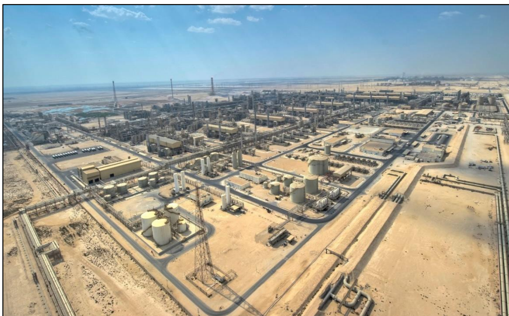
Slika 2-14. UPP terminal „Ras Laffan“ u Kataru (Qatargas, 2021)
