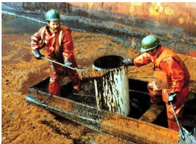
Slika 2-3. Korištenje praha izrađenog od prirodnog anorganskog materijala za sanaciju izljeva ugljikovodika u okoliš (Fingas, 2016)
