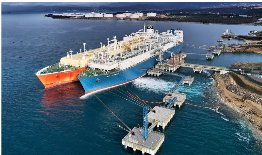
Slika 2-4. UPP terminal u Omišlju, Krk (LNG Hrvatska, 2021)
