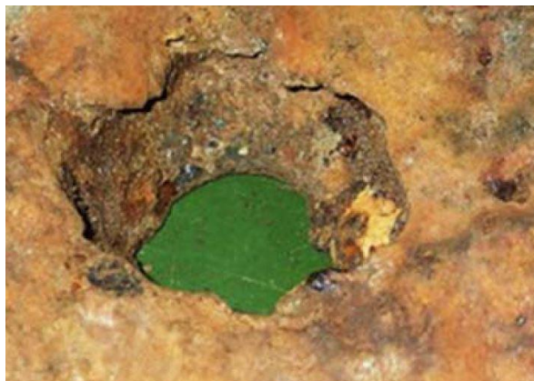
Slika 2-6. Primjer MIC oblika korozije (Bhardwaj, 2020.)
