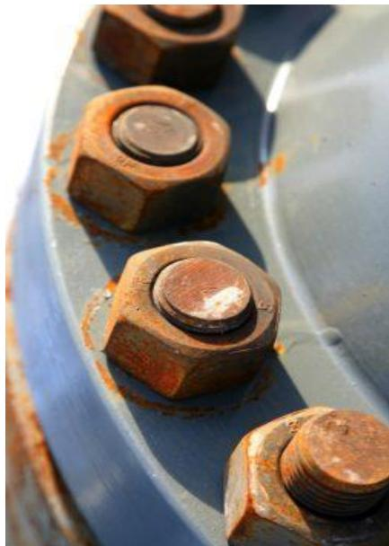
Slika 2-8. Primjer galvanske korozije (Harkin, 2017.)
