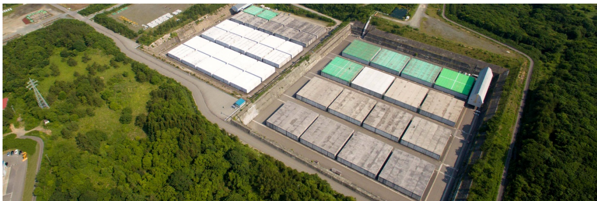
Slika 2.10. Odlagalište Rokkasho (Japan nuclear fuel Limited)
