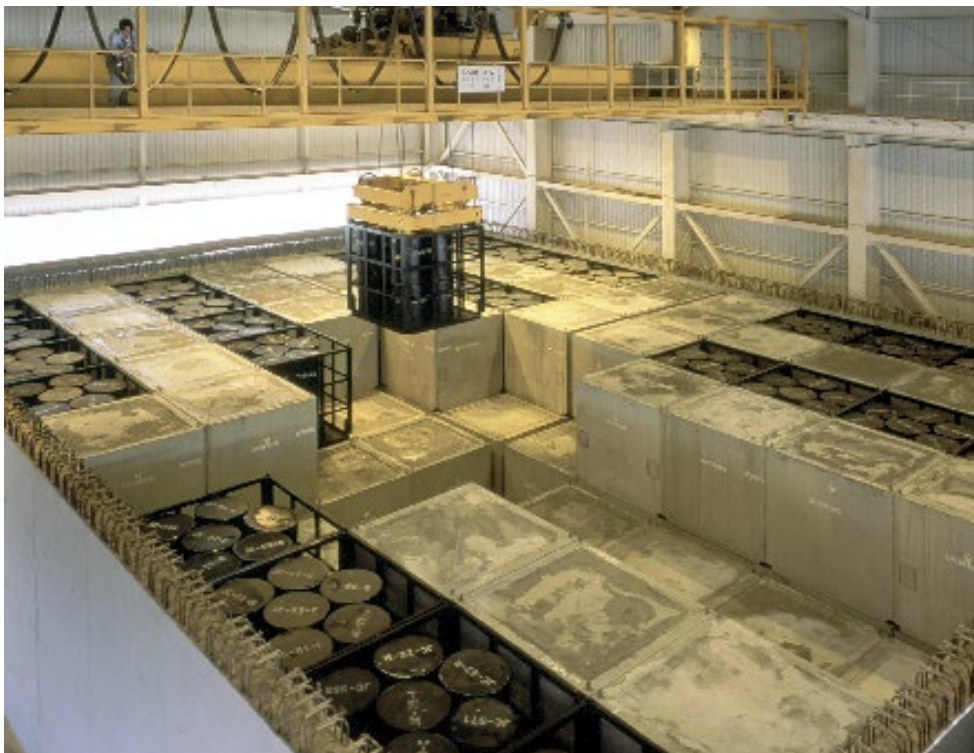
Slika 2.5. Punjenje betonske kasete s kockama (Enresa, El Cabril Disposal Facility)
