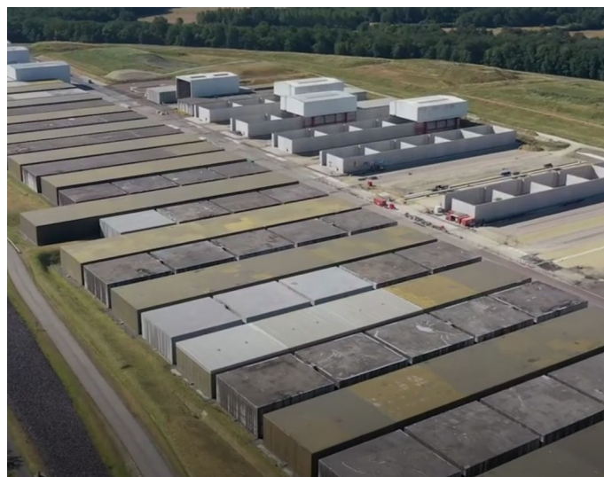
Slika 2.9. Betonske kasete i njihov raspored u odlagalištu (Andra, Nuclear waste in France)
