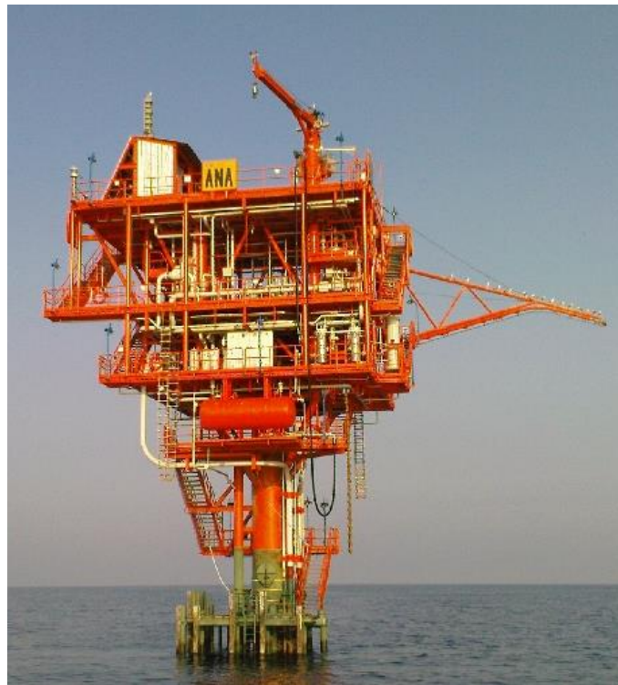
Slika 7-1. Platforma Ana (Fotodokumentacija INAgip)
