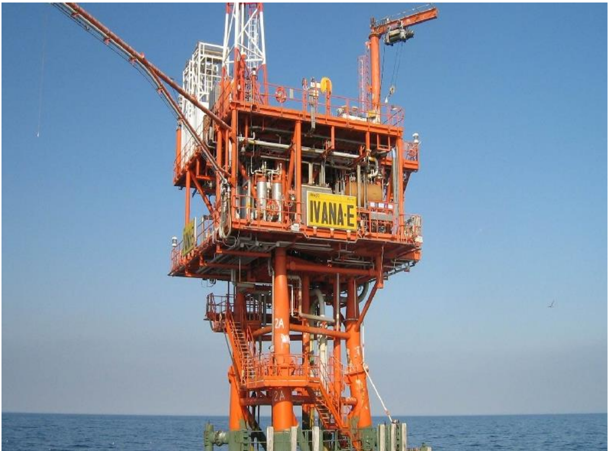
Slika 3-5. Platforma Ivana E (Fotodokumentacija INAgip)
