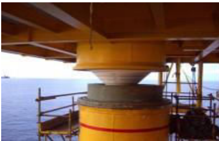
Slika 2-9. Spajanje nadgrađa s trupom spar platforme ( www.offshorekinematics.com )
