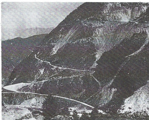
Slika 9 - Staza kliznice transformirana za cestovni promet
