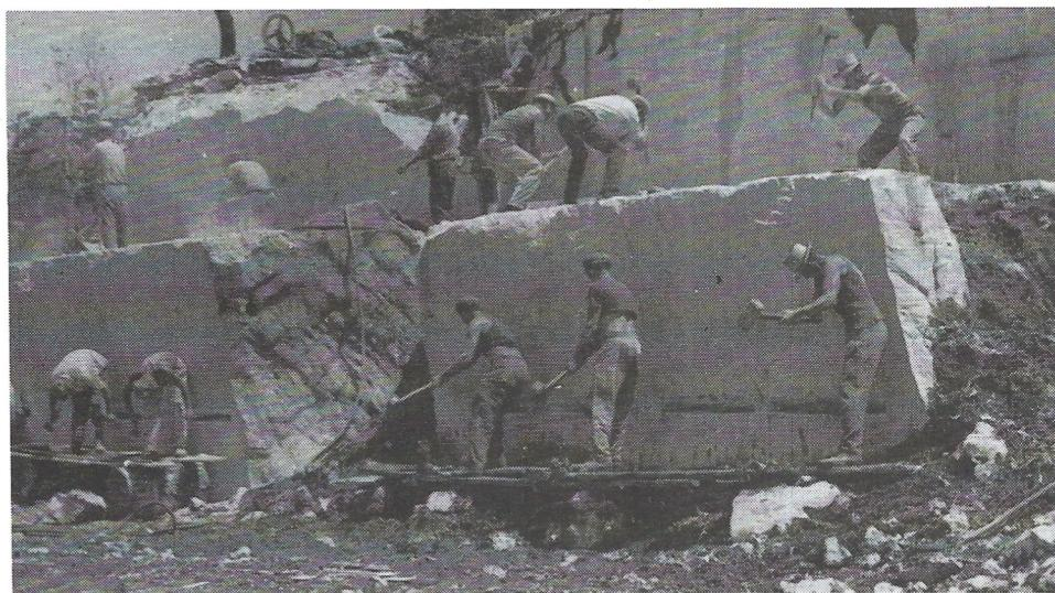
Sl. 11. Kamenolom vapnenca istarski žuti Selina u Istri. Na lijevom bloku jedna grupa radnika izrađuje forme duž slojnice, a druga pneumatskim čekićem buši vertikalne rupe. Na lijevom bloku jedna grupa radnika pobija klinove u formelama, a druga u vertikalnim bušotinama (foto: J. Tišjar, 1963)
