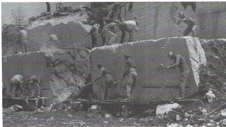
Sl. 11. Kamenolom vapnenca istarski žuti Selina u Istri. Na lijevom bloku jedna grupa radnika izrađuje formele duž slojnice, a druga pneumatskim čekićem buši vertikalne rupe. Na desnom bloku jedna grupa radnika pobija klinove u formelama, a druga u vertikalnim bušotinama (foto: J. Tišljar, 1963)
