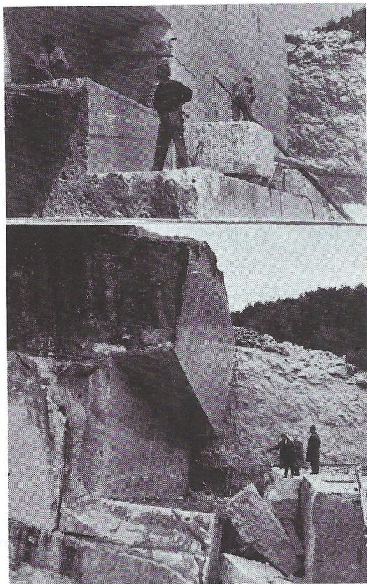
Sl. 15. Kamenolom Valtura u Istri 1964. godine. Horizontalnim rezom između krovinske jalovine i eksplorabilnih slojeva, te vertikalnim rezom pozadi vapnenačkog bloka, izvaden je odvojeni dio vapnenca. Nakon toga krovinska je jalovina vertikalnim rezom i gravitacijski oboren na podinske naslage
