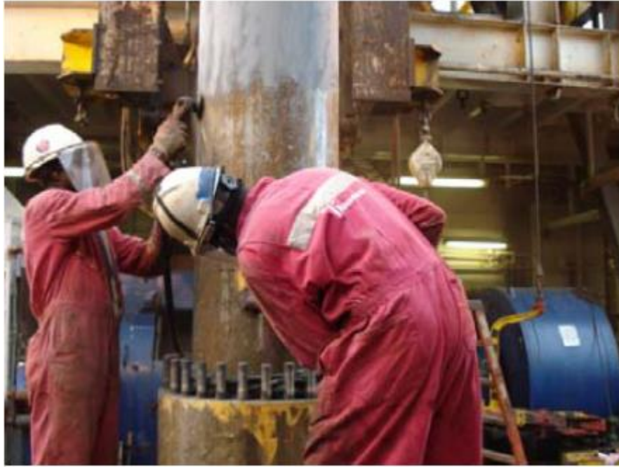
Slika 5-5. Uklanjanje korozije s unutarnje cijevi i tretiranje zaštitnim premazom (Upton, 2009)
